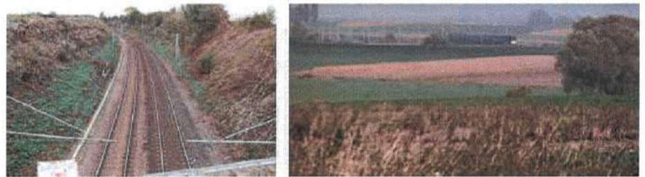
Figure 74 : Voie ferrée de Caudry à Cambrai (à Awoingt) et vue zoomée du site depuis la voie
