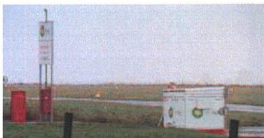
Figure 116 : Cuve de carburants sur l'aérodrome de Cambrai-Niergnies
