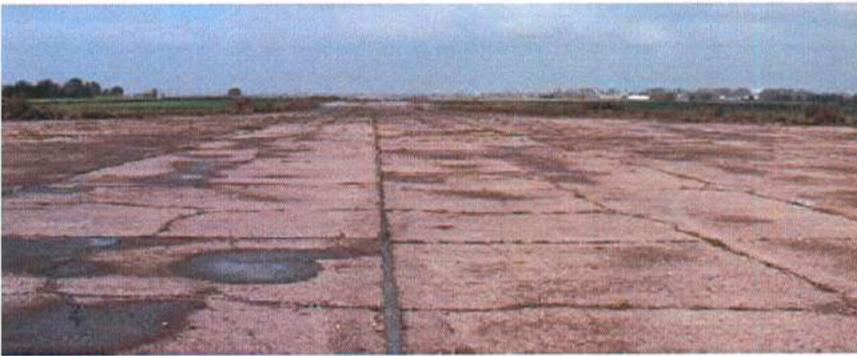
Figure 13 : Piste d'axe Sud-Est/Nord-Ouest (vue depuis le Sud en direction du Nord-Ouest)
