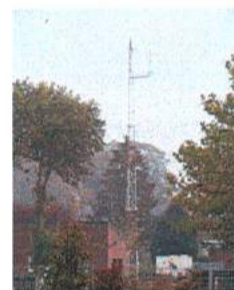
Figure 130 : Antenne de radiotéléphonie sur la commune de Niergnies
