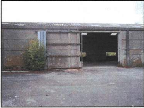
Figure 57 : Hangar utilisé comme gîte estival (Rainette, 2011)
